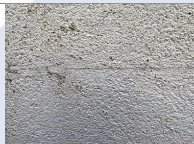
Afb. 17-18 Zoals reeds beschreven bij afbeelding 7, 8 en 9, verlopen de aanwezige scheuren vrijwel allemaal horizontaal en verticaal. Ongeveer 90% van deze scheuren volgt de naden van de onderliggende isolatieplaten. De spanning in de naden is altijd hoger dan in het midden van de platen, zeker wanneer de naden met mortel zijn gevuld.
