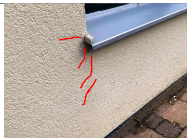
Afb. 16 Idem opmerking afb. 14-15. Haarscheuren in de pleisterlagen veroorzaakt door uitzetting van de aluminium waterslagen met vaste kopschotten.
