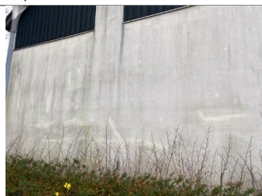
Afb. 16 Idem opmerking afb. 14-15. Haarscheuren in de pleisterlagen veroorzaakt door uitzetting van de aluminium waterslagen met vaste kopschotten.
