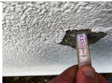
Afb. 43 De isolatiedikte op de kopgevel bedraagt 6 cm.
